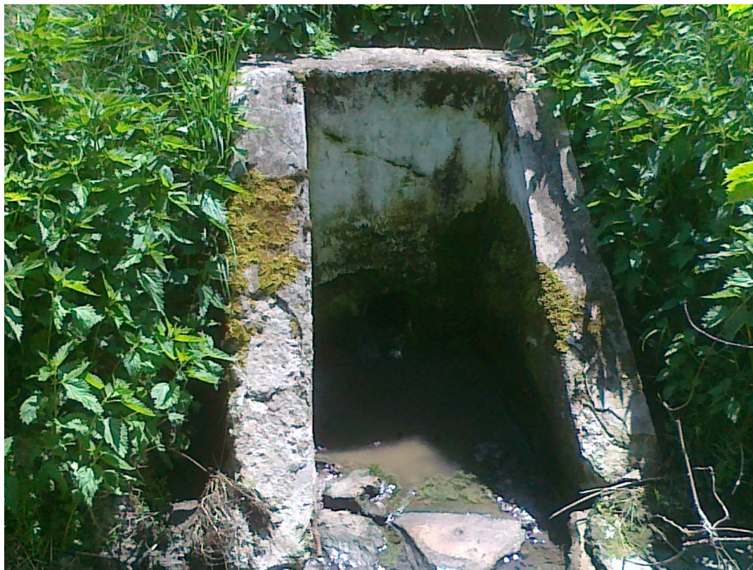
Widok istniejącej konstrukcji wylotu kanału ścieków oczyszczonych
